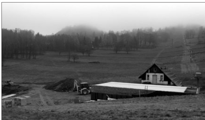
Práce na dolní stanici Meze
