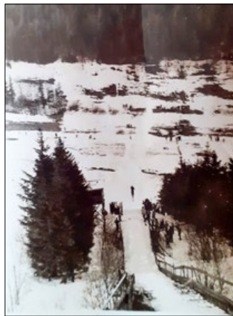
Pohled z nájezdové věže
